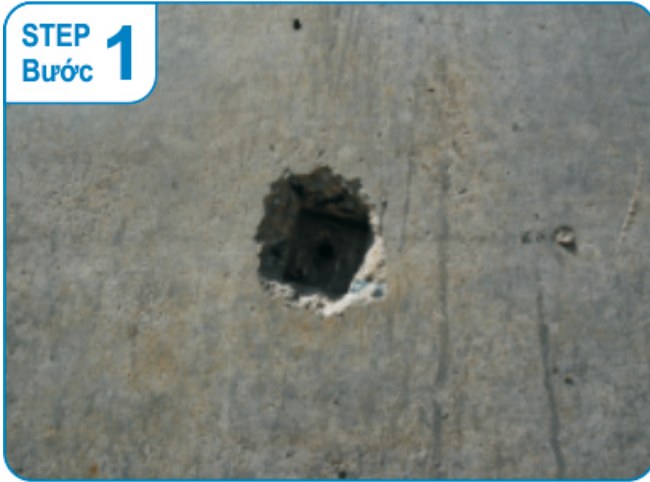
CHIP OF TO FORM A "HOLE" 50 X 50MM Đục lỗ ty rộng 50 x 50 mm
