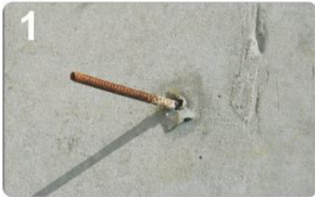
1 Coin holes, tie bar on the wall Lỗ ty trên tường chân đất tầng hầm
