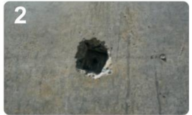
2 Chip of to form a "hole" 30 x 30 x 30mm Đục lỗ ty rộng 30 x 30 x 30mm
