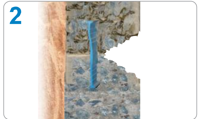
2 CHIP OFF LEAKAGE POINT TO FORM A "V" GROOVE DỤC KHU BỊ THẤM, TẠO KHE CHỮ "V" NHƯ HẦM ÉCH
