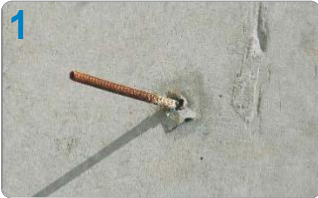
COIN HOLES, TIE BAR ON THE WALL LỖ TY TRÊN TƯỜNG CHẮN ĐẤT TẦNG HẦM
