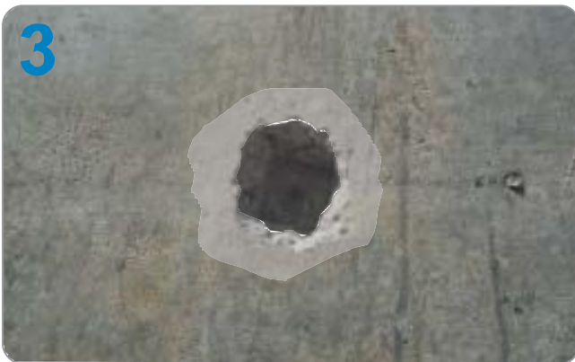
APPLY 1 COAT OF LATEX ONTO THE COIN HOLE QUÉT 1 LỚP PHỤ GIA LATEX LÊN BỀ MẶT LỖ TY
