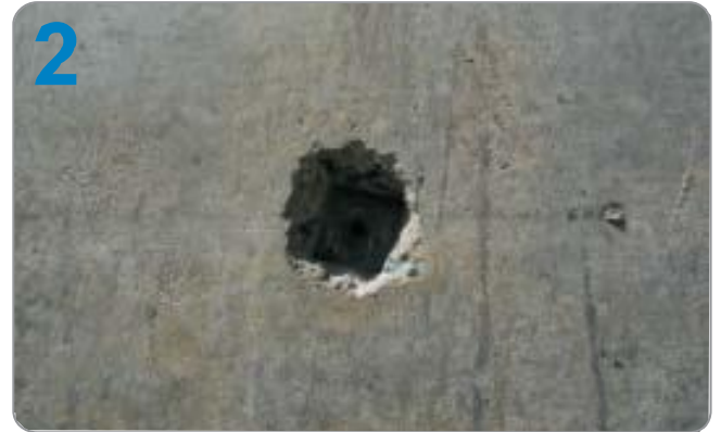
CHIP OF TO FORM A "HOLE" 30 X 30 X 30MM ĐỤC LỖ TY RỘNG 30 X 30 X 30MM
