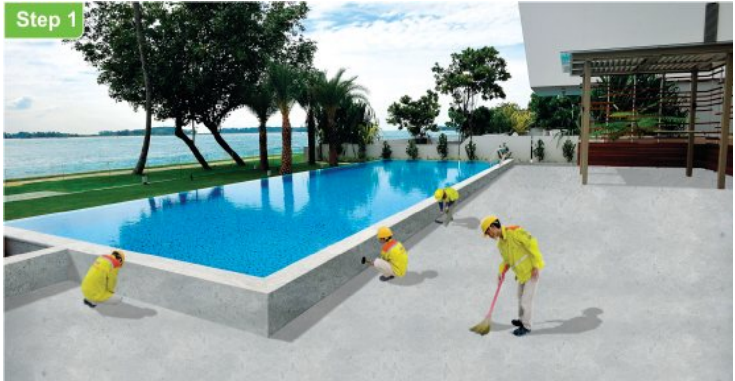
Step 1 Cleaning the surface Bước 1 Chuẩn bị mặt bằng đã được vệ sinh sạch sẽ
